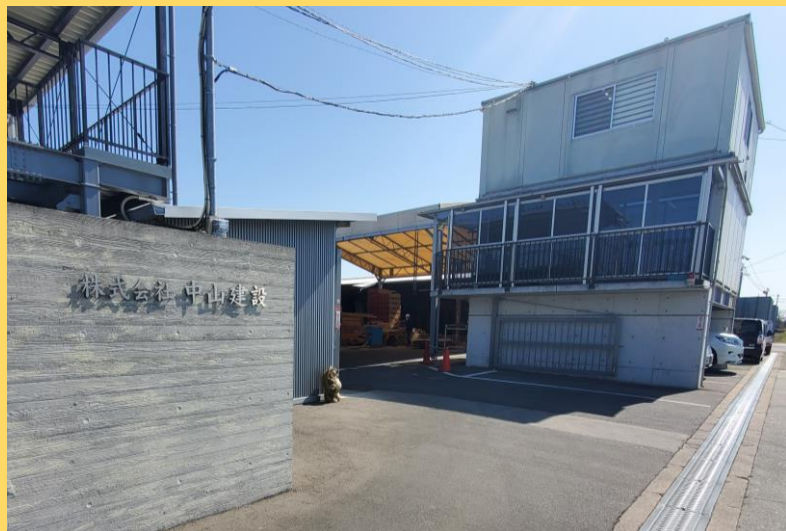
事務所・資材センター
